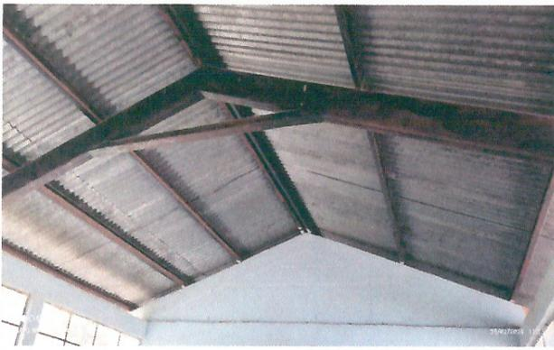
Foto 3: Módulo 2, estructura de techo
